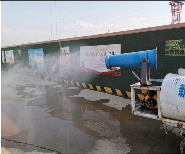
图 3-3：施工四周设围挡、喷淋装置及洒水车
