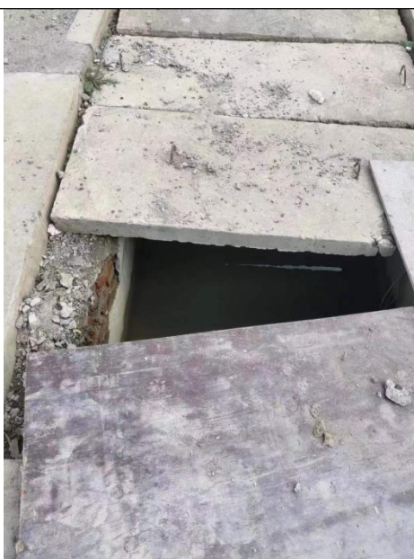
图 3-1：施工期设置的临时沉淀池
