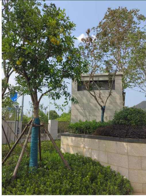
图 3-4：地下车库排风口
